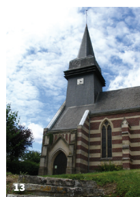
10 • Eglise de Vauvillers
