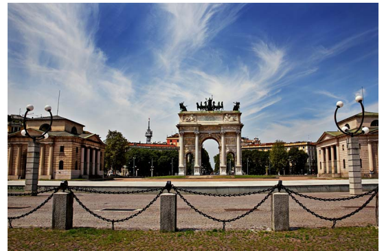
Construction de la place de la Paix à Milan (1807-1838)
